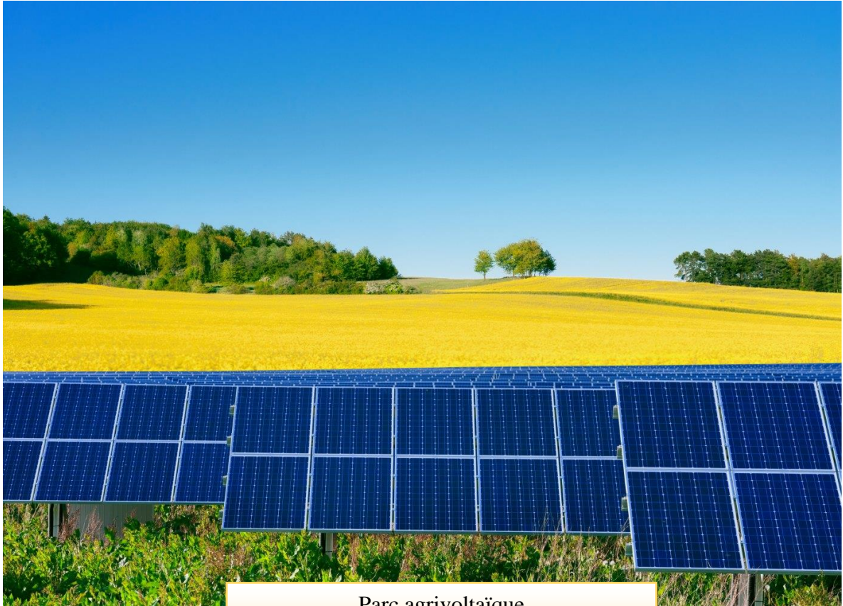
Parc agrivoltaïque Panneaux montés sur châssis surélevés
